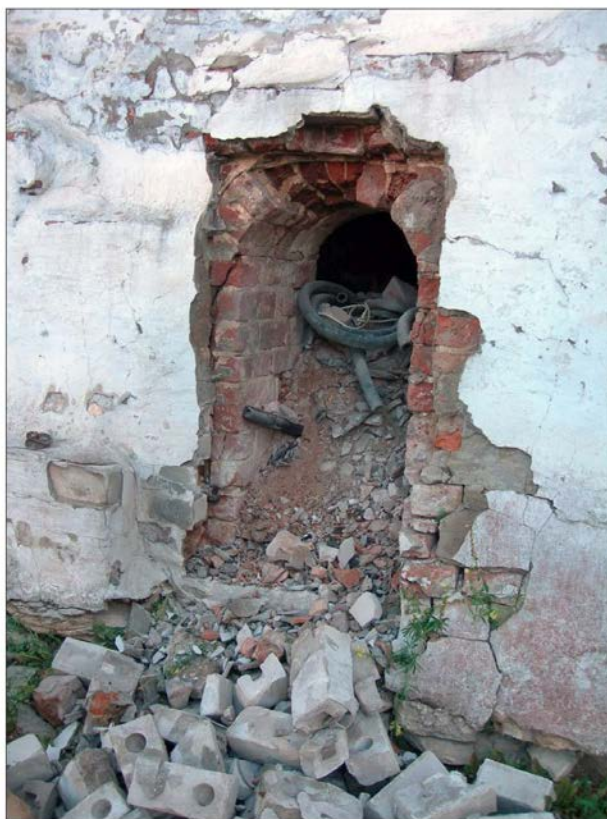
Слева: интерьер камеры под лестницей с погребением монаха Космы. Справа: Разборка реставраторами входа в камеру под лестницей, заложенной силикатным кирпичом. Фото 2024 г.
