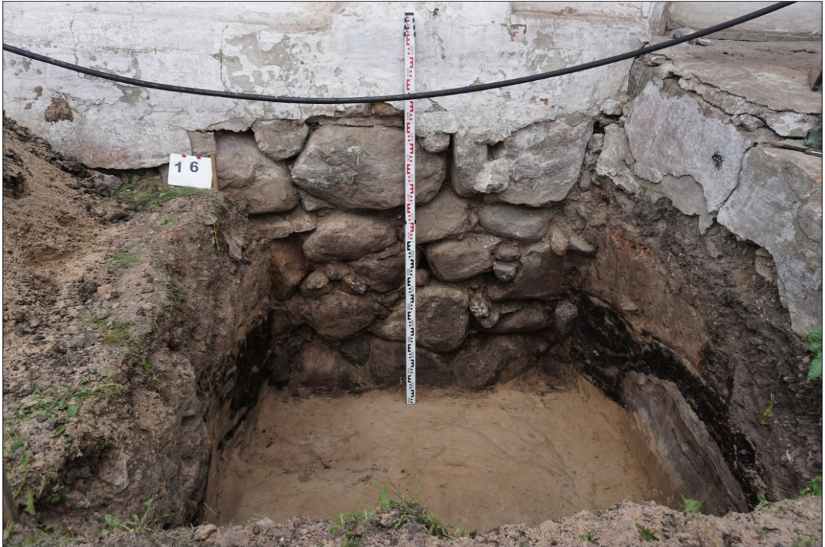
Фундамент западной паперты Никольского собора. Фото 2024 г.
